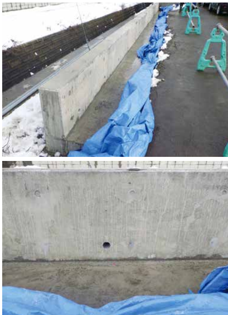
写真2 作製した鉄筋コンクリート壁
