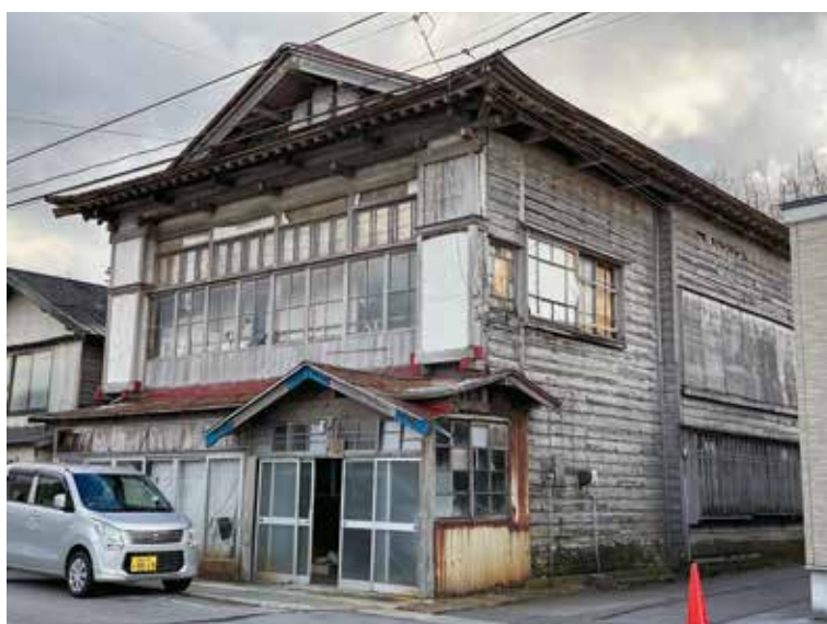
写真3 旧中村家住宅外観
